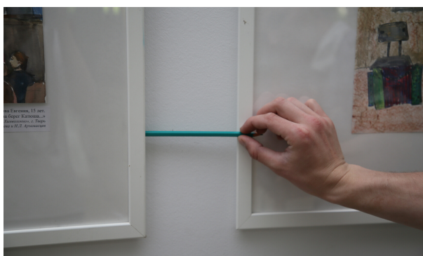
проверяем интервалы при помощи карандаша
