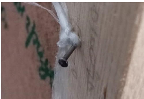
гвоздь вбит в раму под углом 45°
